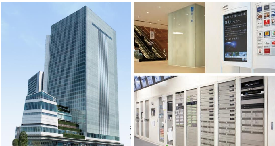
マルチサイン設備との連動や多言語・多元放送対応した 避難誘導支援システムを横浜市役所に納入
