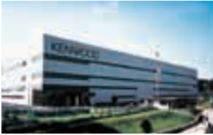
マレーシア工場
