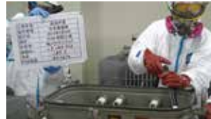
低濃度 PCB 汚染物保管倉庫内での抜油作業
