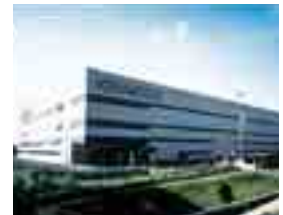
マレーシア工場
