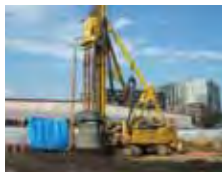
土壌汚染浄化作業
