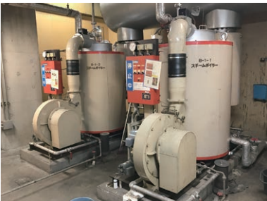
廃止前の化石燃料使用ボイラー(JVCケンウッド長野)
