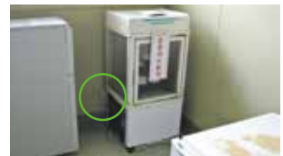
発煙硝酸保管冷蔵庫の固定
