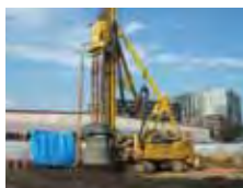
土壌汚染浄化作業
