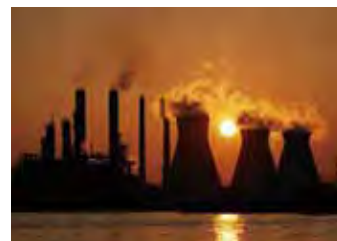
防爆無線機が使われている発電所
