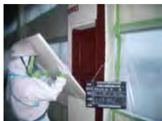
アスベスト除去工事状況
