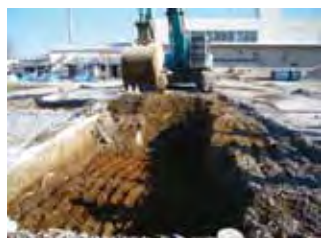
汚染土壌掘削作業
