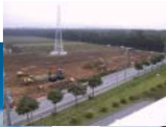
長野工場の隣接地
